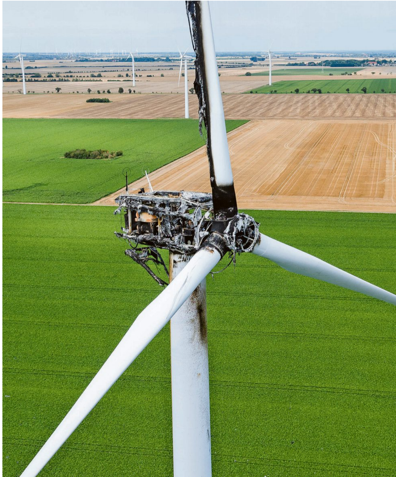
Gefahr durch Blitzschlag: Ausgebranntes Windrad, vor drei Jahren in Sachsen-Anhalt
